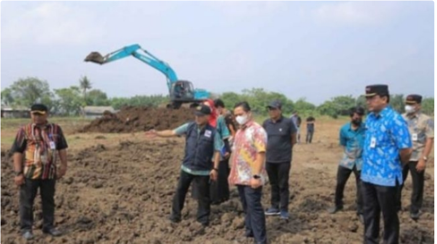
Wali Kota Tangerang Arief R Wismansyah, meninjau pembangunan venue arena Grasstrack
